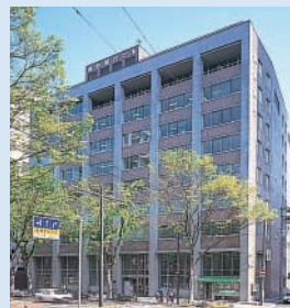
(本店 / 昭和44年竣工)
