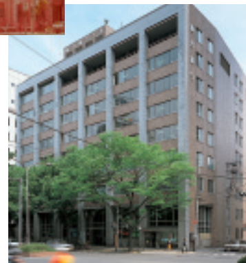
本店（昭和44年竣工）
