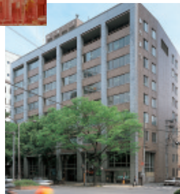
本店（昭和44年竣工）
