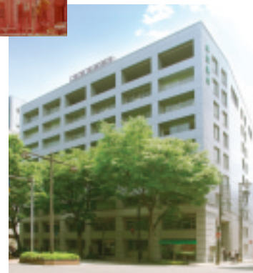
本店（昭和44年竣工）
