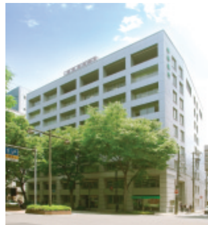
本店(昭和44年竣工)
