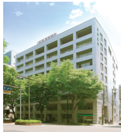
本店（昭和44年竣工）
