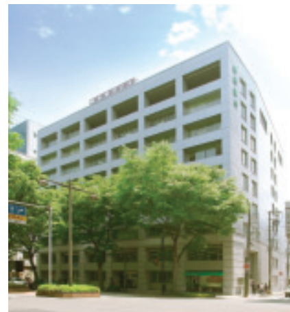
本店(昭和44年竣工)
