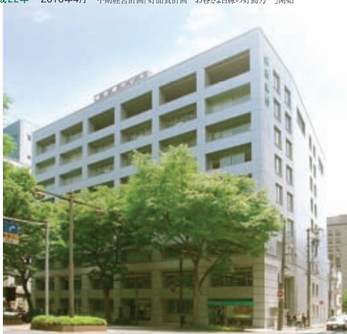
本店(昭和44年竣工)
