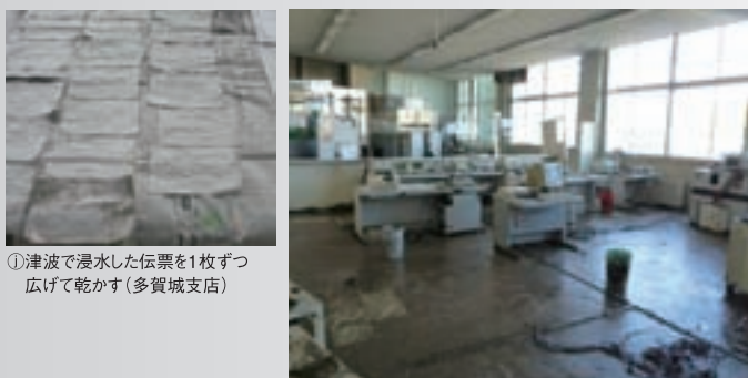
①津波で浸水した伝票を1枚ずつ広げて乾かす(多賀城支店) ①津波に含まれた重油が建物内に残る多賀城支店内部。津波により店内の全てが浸水し、端末機等は全て使用不能となる
