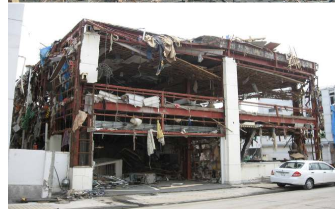
(写真上) 当行志津川支店周辺の津波後の状況 (宮城県南三陸町) (写真下) 津波で全壊となった当行女川支店 (宮城県女川町)
