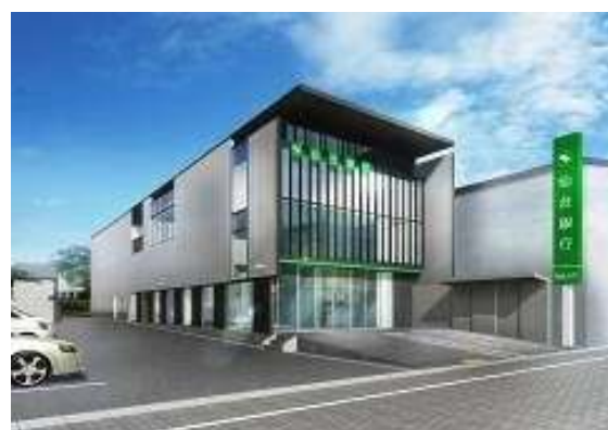
新・塩釜支店（平成 25 年 7 月）
