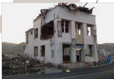
津波で被災した志津川支店 (登米市の津山支店内に一時移転)
