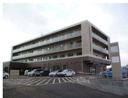
石巻市津波避難ビルに認定
