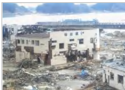
津波で被災した歌津支店 (気仙沼市の津谷支店内に一時移転)
